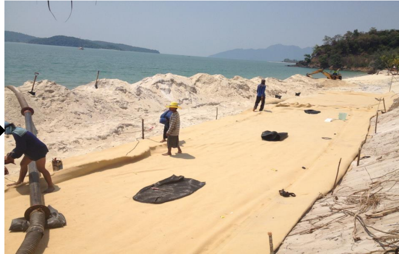
Installing scour apron
